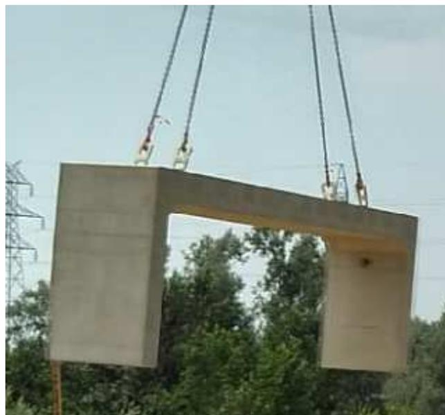
Generalmente los marcos y las galerías se colocan de abajo hacia arriba. Con la embocadura macho situada “aguas abajo” y preparada para recibir la siguiente pieza para instalar.
