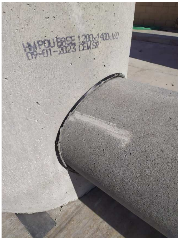
Junta acometida para tubo de hormigón
