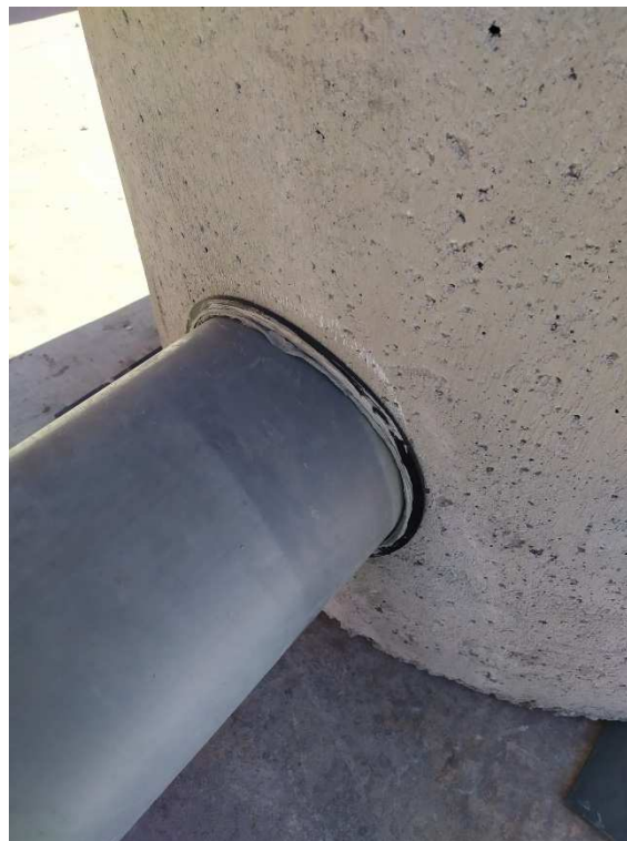
Junta acometida para tubo de plástico
