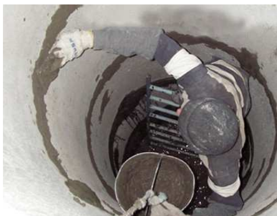
Rejuntado interior de pozo H/M J/R
