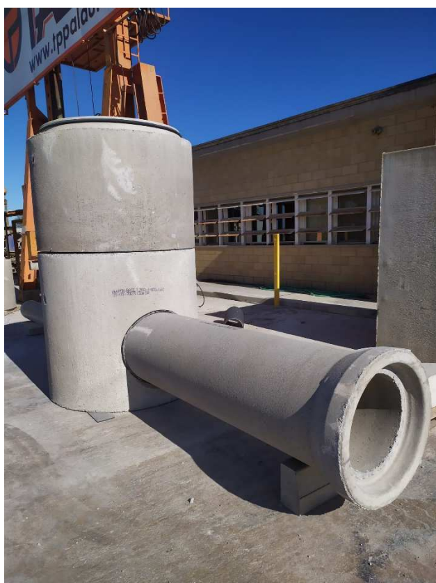
Acometida tubo de hormigón
